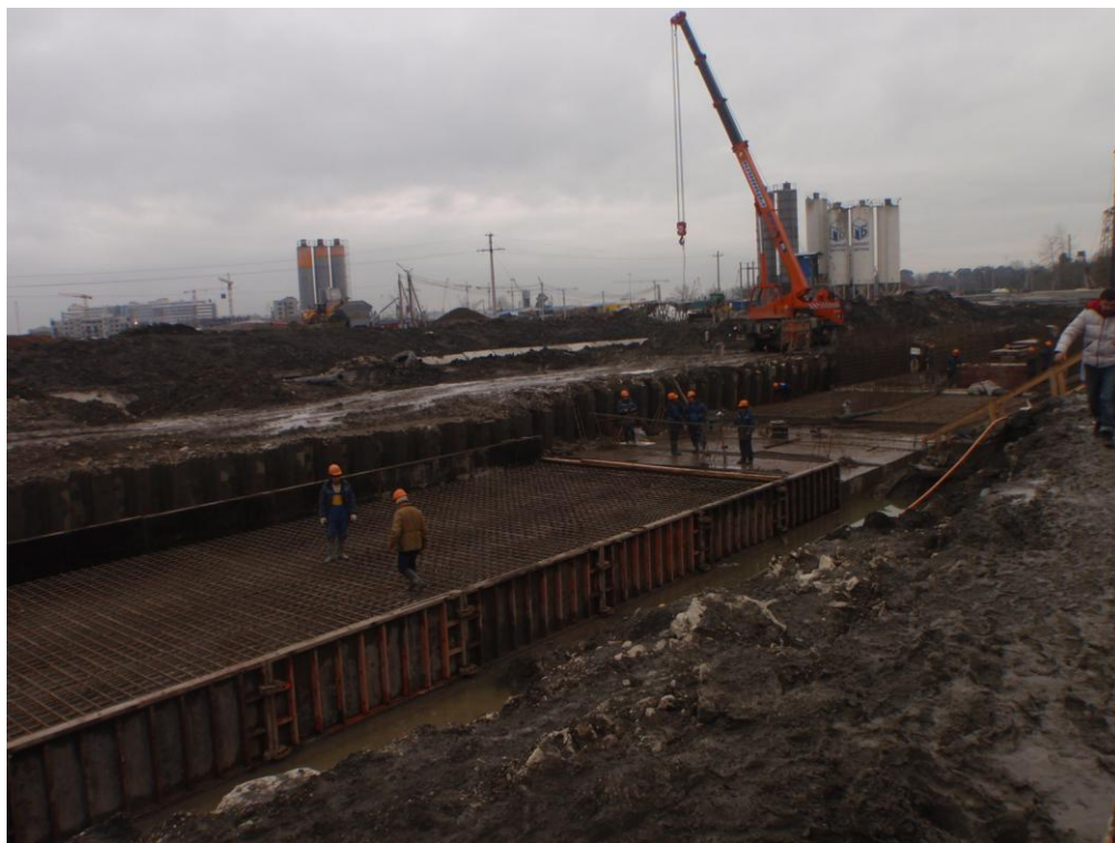
Рис. 3. Работы по переустройству магистрального канала в рамках создания инженерной защиты территории Имеретинской низменности.
